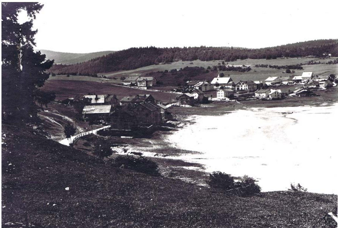
La maison de Fritz Rochat est en construction. 1899-1900.
